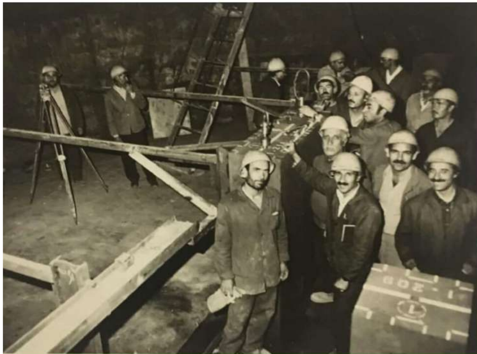
نصب کربن بلوک های کوره بلند در تعمیرات اساسی درجه یک با همت کارشناسان ایرانی
